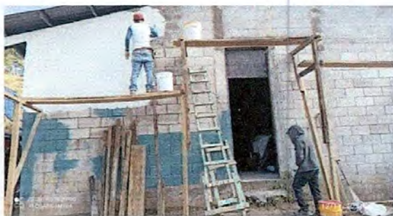
FOTO 11: MANTENIMIENTO DE PARED Y PINTURA
