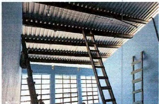
FOTO 7: REPARACIÓN DE SISTEMA ELÉCTRICO
