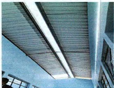
FOTO 1: SUSTITUCIÓN DE CAPOTE DE LÁMINA
