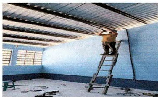
FOTO 8: SUSTITUCIÓN DE LÁMPARAS
