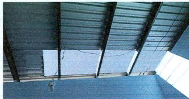
FOTO 2: SUSTITUCIÓN DE LÁMINA
